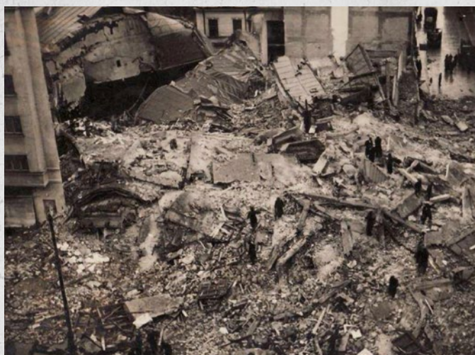
Imagini în proprietatea Institutului Național de Fizică a Pământului, România 1977 Fig. 1.7 – Tipuri de cedări: colaps complet clădiri, avariere moderată, avariere minoră.
