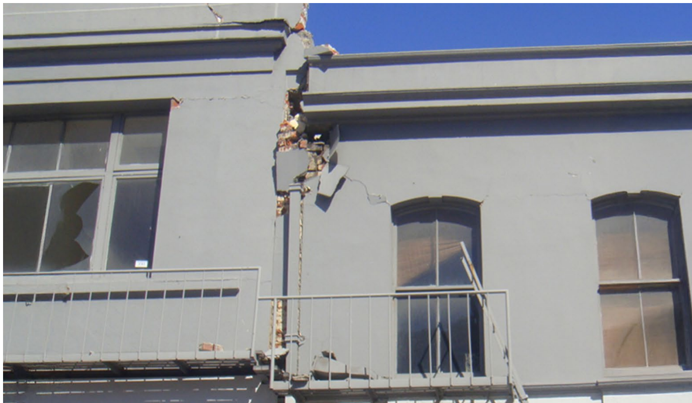
Fig. 6.10 – Rost de separație insuficient
