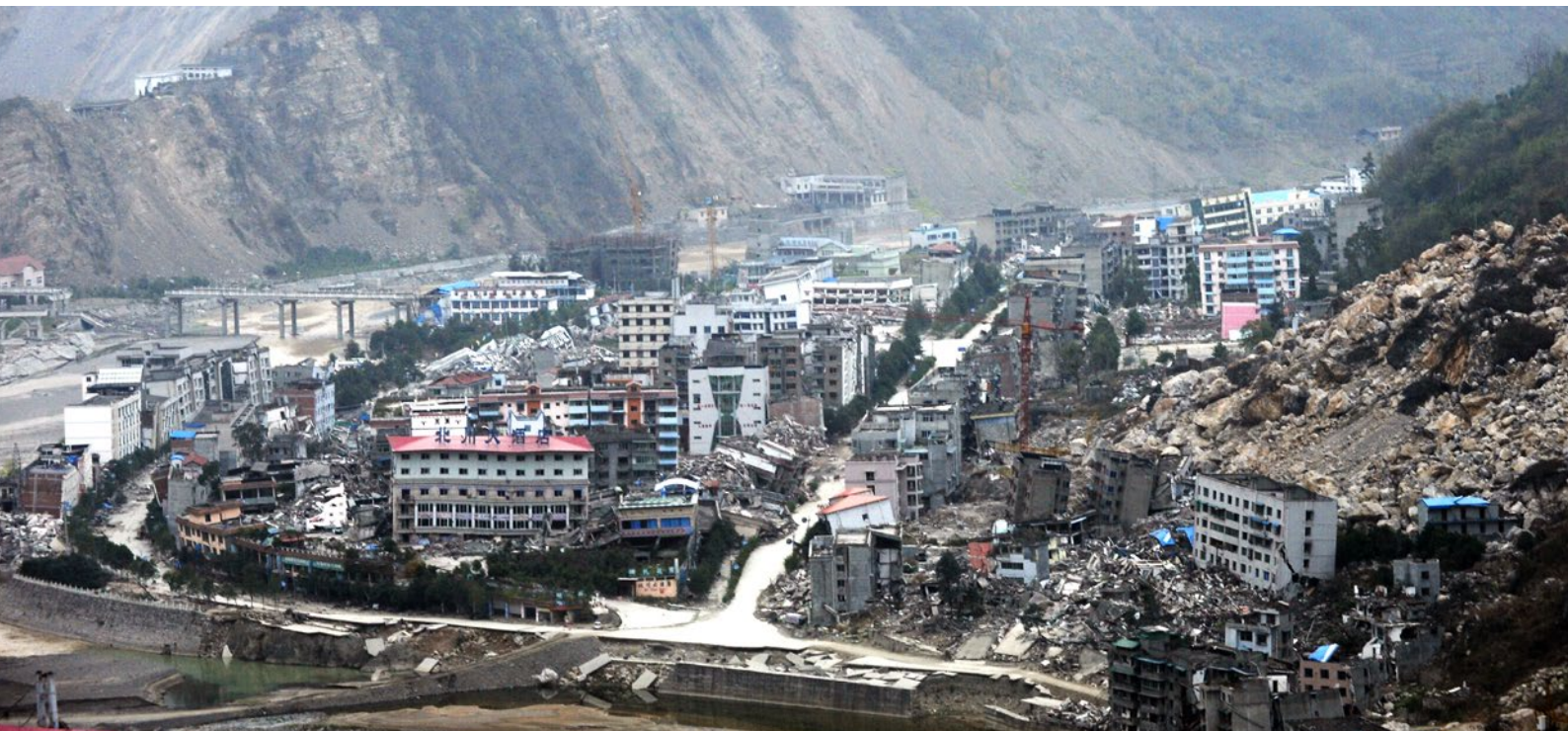
Fig. 1.5 – Clădiri avariate/distruse de cutremur.
