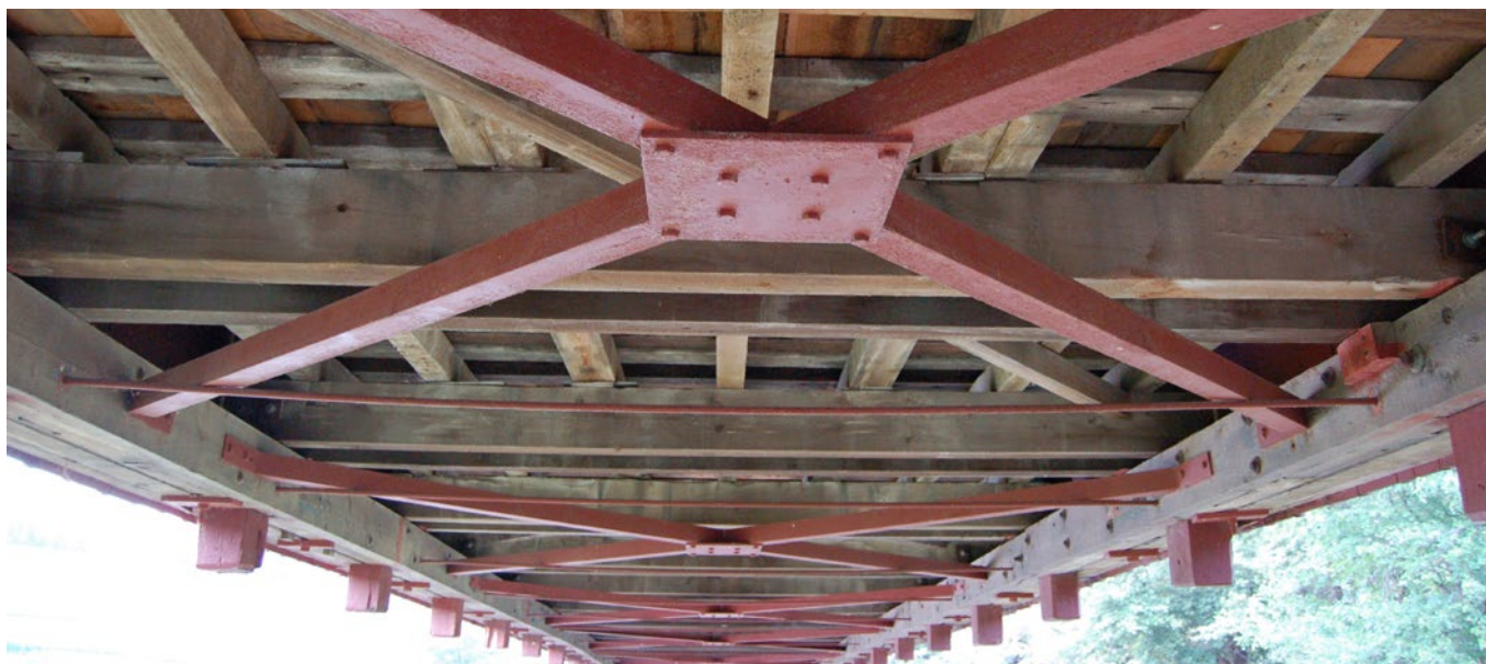
Fig. 6.7 – Diagonale metalice pentru rigidizare planșee fără placă de beton.
