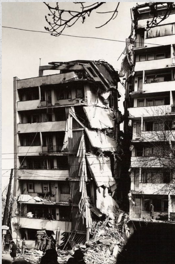
Imagini în proprietatea Institutului Național de Fizică a Pământului, România 1977 Fig. 1.7 – Tipuri de cedări: colaps complet clădiri, avariere moderată, avariere minoră.
