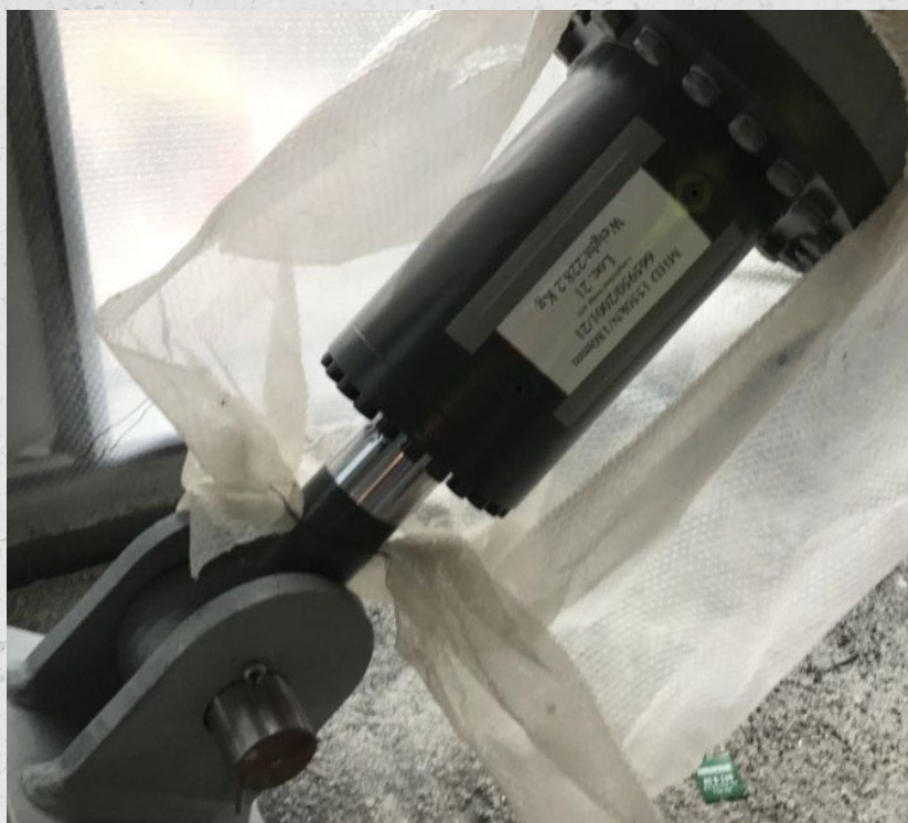
Fig. 5.12 - Amortizori vâscoși - Orhideea Tower, București (imagine utilizată cu acordul Popp & Asociații).
