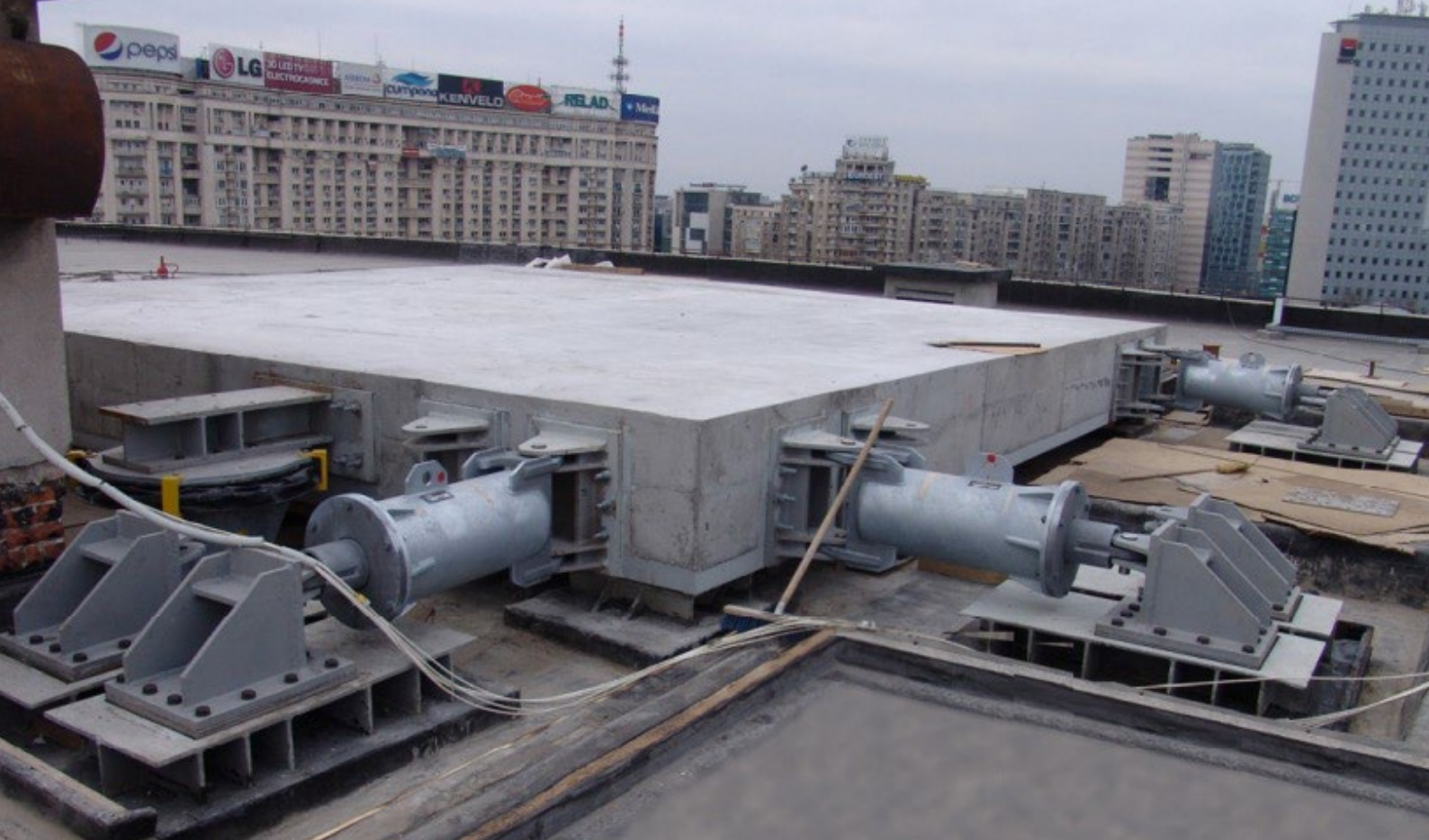
Fig. 5.14 – Sistem cu masă acordată, cu amplasare deasupra clădirii - Palatul Victoria, București (imagine utilizată cu acordul Popp & Asociații).
