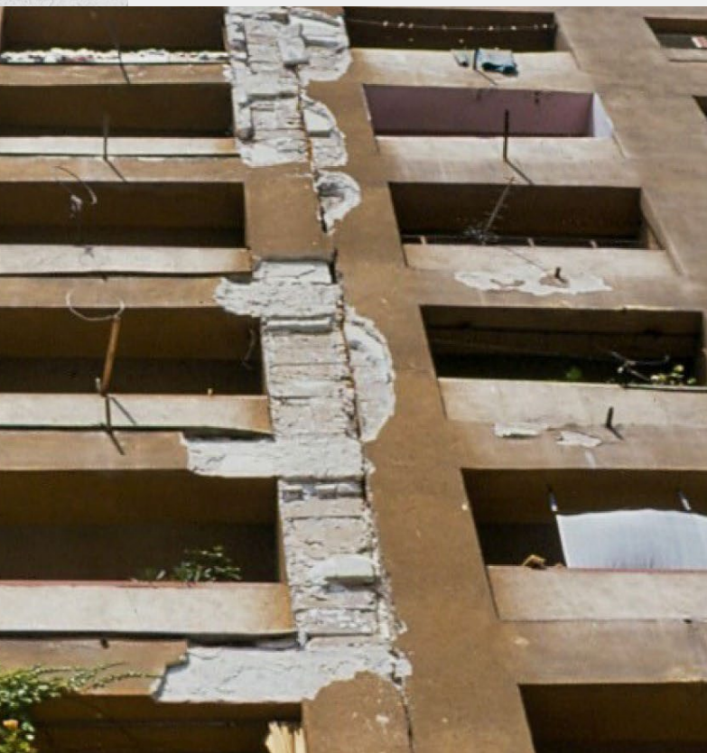
Fig. 4.7 – Degradare structurală datorată deplasărilor excesive ale clădirilor.
