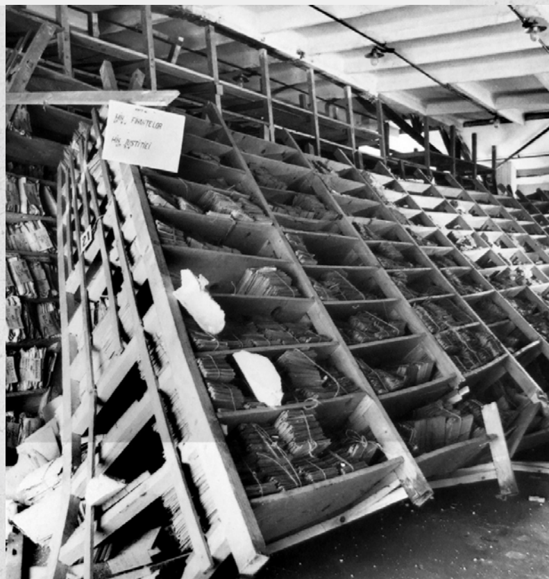
Fig. 4.8 – Efectele cutremurului asupra elementelor nestructurale
