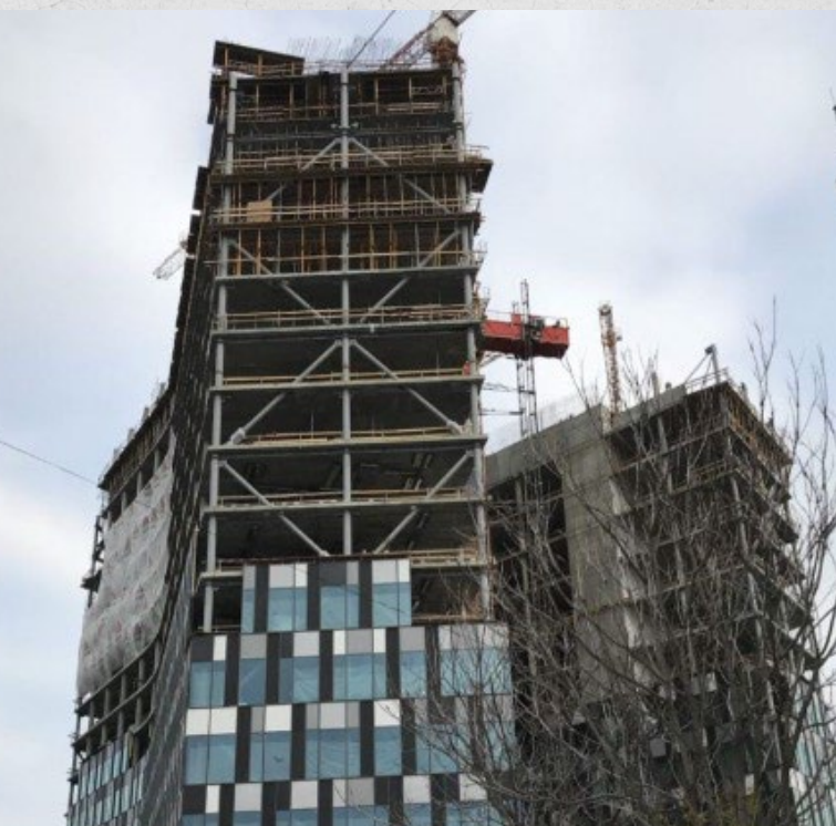
Fig. 5.12 - Amortizori vâscoși - Orhideea Tower, București (imagine utilizată cu acordul Popp & Asociații).
